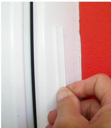
Ein kurzes Stück (ca. 10 cm) des Profils abschneiden, Gewebeteil des Profils entfernen. Schutzpapier des Dichtbandes abziehen und das Profilstück fest andrücken.
