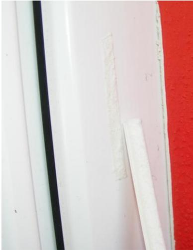
Das Dichtband muss zur einen Hälfte komplett am Profil und zur anderen Hälfte komplett am Untergrund haften bleiben (durchgängiger Schaumbruch).
