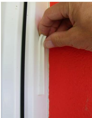
10 Minuten warten. Um das Profil richtig greifen zu können, kann die Leiste am oberen Bereich etwas angehoben werden, anschließend die Leiste ruckartig und kraftvoll wegziehen.
