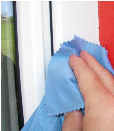
Vorliegendem Untergrund an verdeckter Stelle reinigen. (Der Untergrund muss eben, trocken und staubfrei sein. Haftmindernde Rückstände sind zu entfernen).
