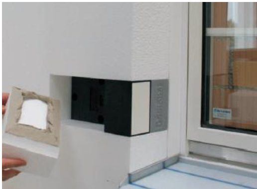
Dämmplatten fugenfrei anpassen. Genaue Lage markieren, damit der TragWinkel nach dem Aufbringen der Putzbeschichtung wieder auffindbar ist.
