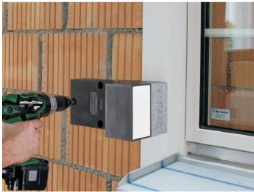
Versetzen des TragWinkels.
